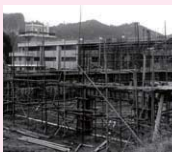
開校以降、校舎の工事が着々と行われました（写真は昭和40年4月）
