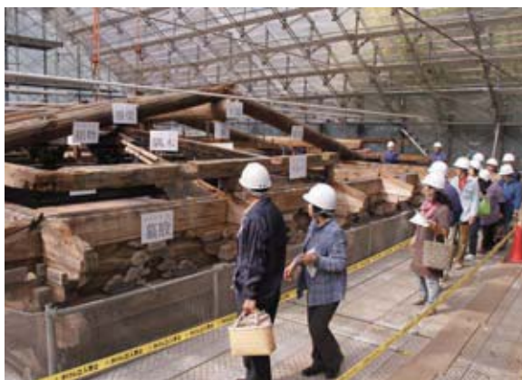
保存修理工事中の本堂を見学できる貴重な機会になりました
