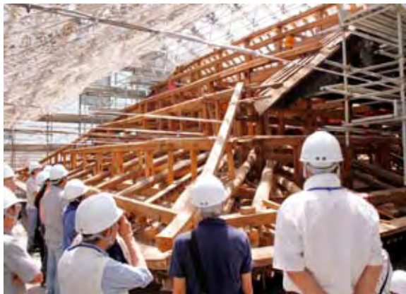
部材の取り外しが進む本堂の屋根部分
