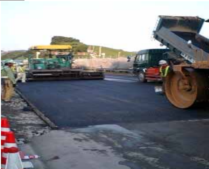
アスファルト舗装工
