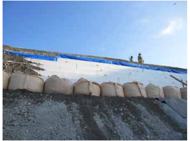
大型発泡スチロールブロック施工
