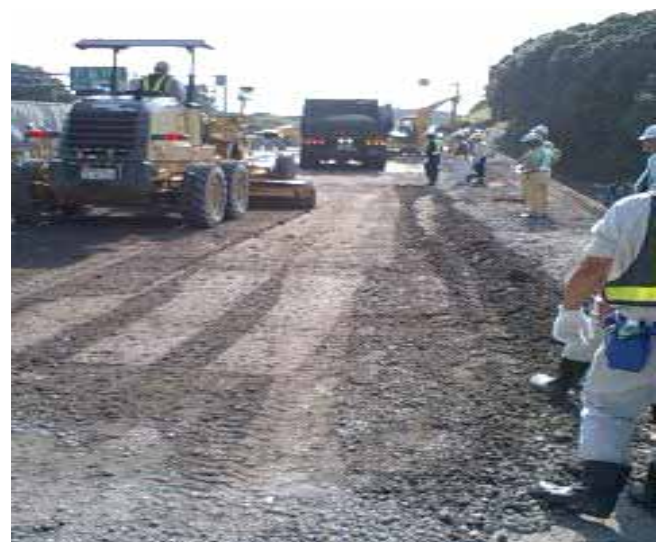
セメント安定処理路盤工
