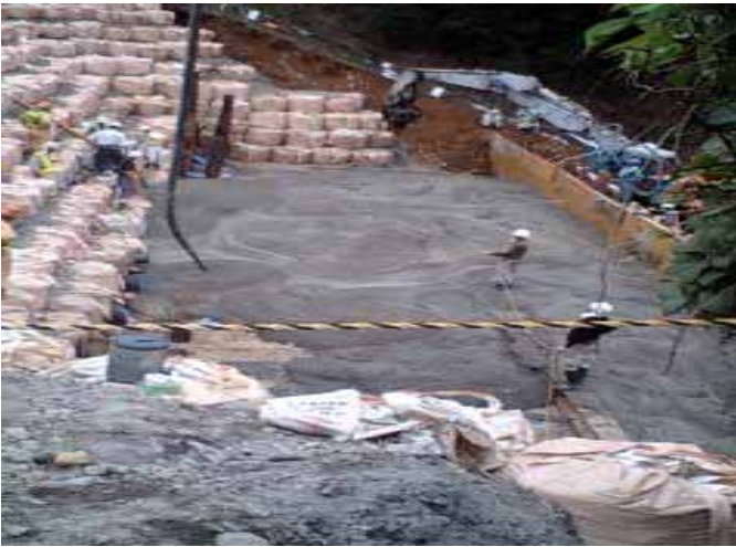
コンクリートによる押え盛土工
