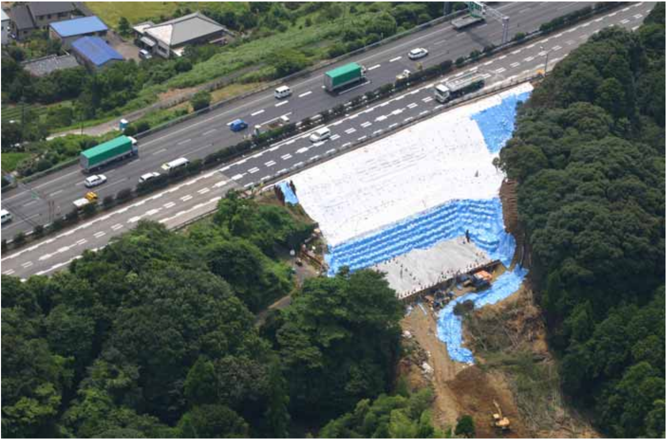
< 応急復旧完了の上空写真 >
