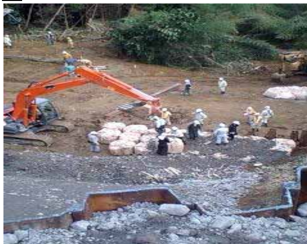
大型土のう設置
