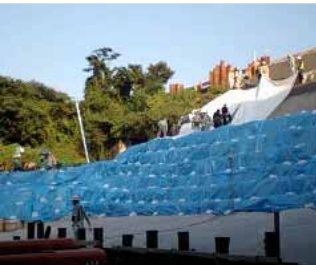
のり面シート養生
