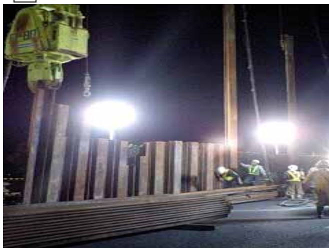
中央分離帯鋼矢板打込
