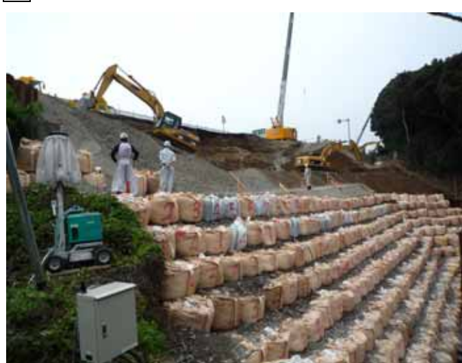
上段盛土セメント安定処理施工
