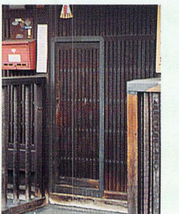
大戸は大きな荷物の出入と防犯の二つの機能を両立させる
