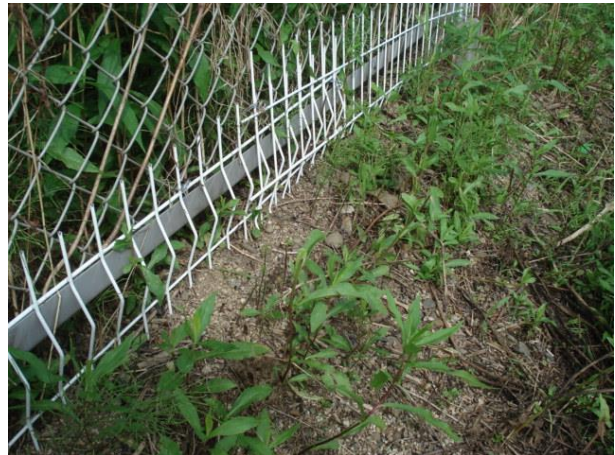
図3. フェンス下部の隙間閉鎖状況
