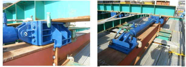
スライドシップジャッキ(1000kN) 水平ジャッキ(押 500kN)
