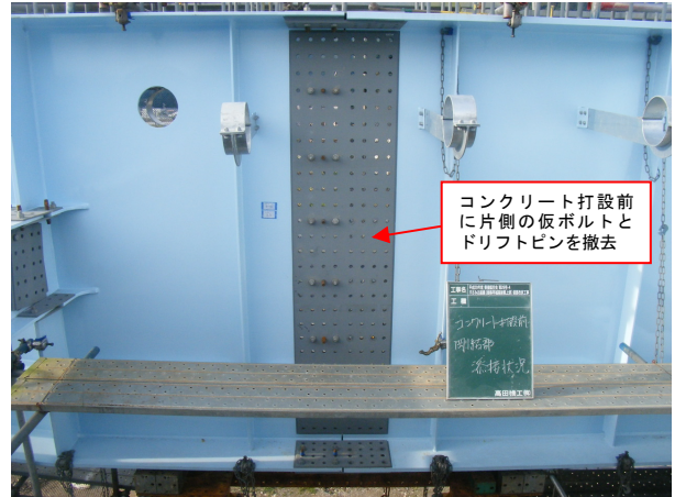
写真-5 剛結部連結状況
