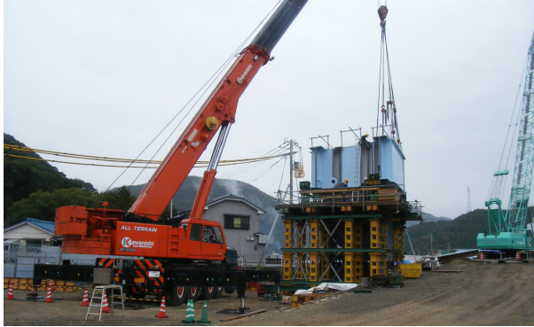
写真-3 P4橋脚架設状況
