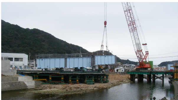
写真-1 架設ステージ上からの架設状況
