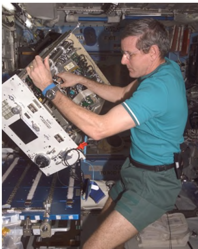
図3.4-7 故障した装置(揮発性有機物分析器(VOA))の修理
