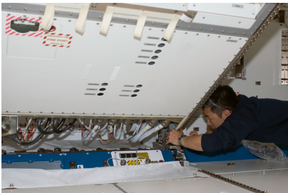
図3.4-11 「きぼう」内のラックの電力・通信・流体配管の接続作業
