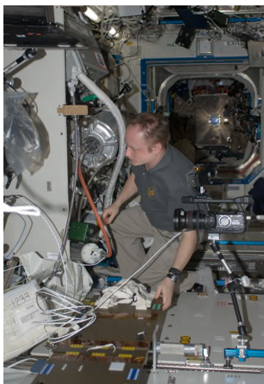
図3.4-10 水再生システム(WRS)ラック 尿処理装置のトラブル対応作業
