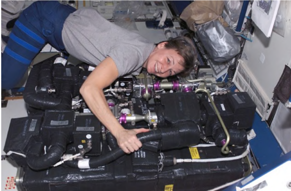
図4.2-4 米国の二酸化炭素除去装置(CDRA) (修理時の写真)
