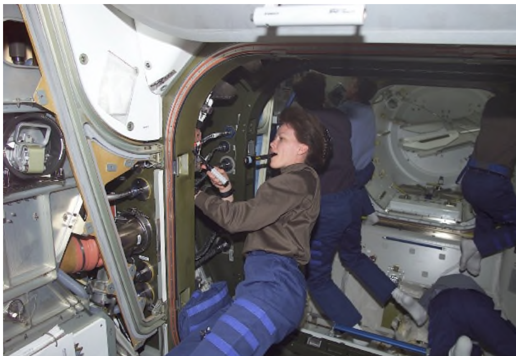
図3.4-9 米国モジュール間での電力・通信・流体配管の接続作業
