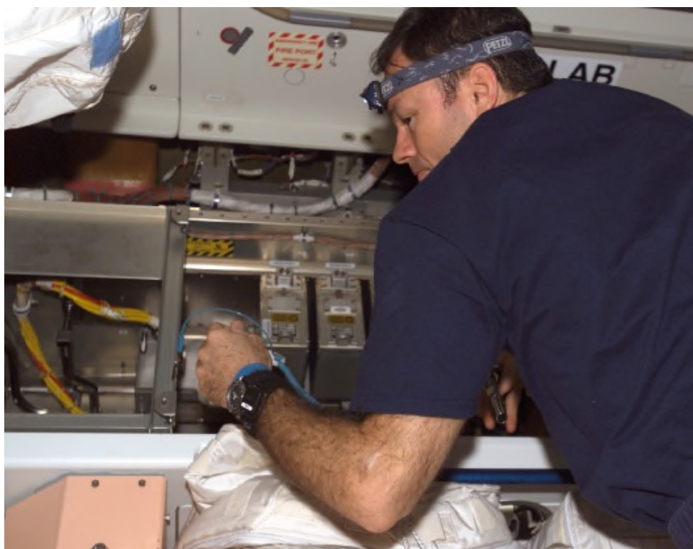
図3.4-4 遠隔電力制御モジュール(RPCM)の交換修理 (ユニティ内)
