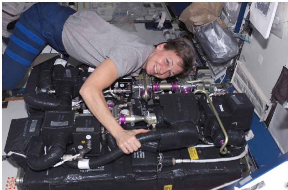
図3.4-3 米国の二酸化炭素除去装置(CDRA)の修理 (デスティニー内)
