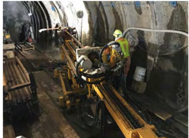
写真-1 水圧ハンマー削孔機
