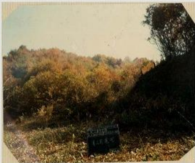
工事前の城山中学校(11月20日)
