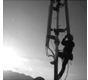
【情報通信設備工事】
