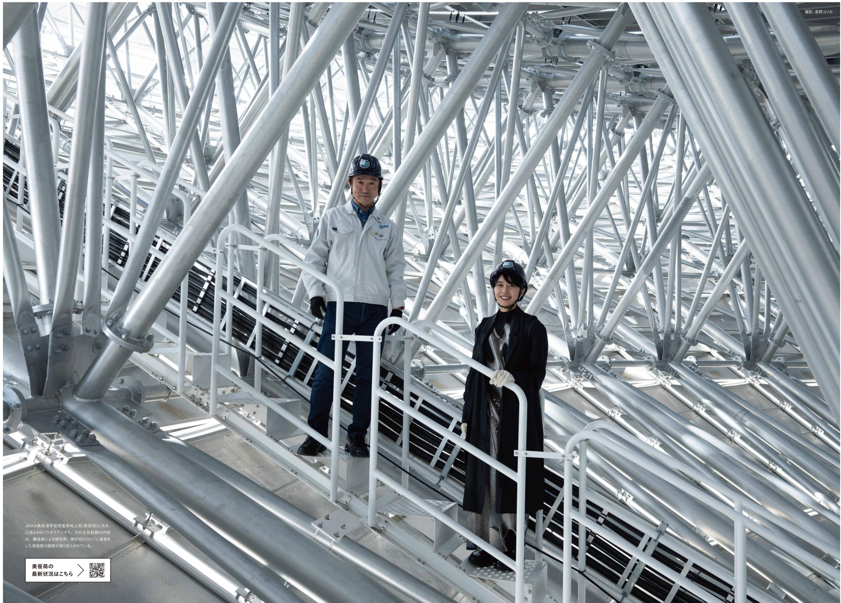
JAXA美笹深宇宙探査用地上局(美笹局)にある、口径54mパラボラアンテナ。その主反射鏡の内部は、構造美による銀世界。熱が伝わりにくい塗装をした高強度の鋼管が張り巡らされている。
