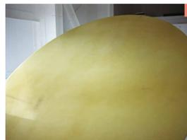
6. パラボラアンテナには主反射鏡と副反射鏡というふたつの鏡がある。写真は主反射鏡の中心部。主反射鏡の開口径は54m、3mm厚のアルミバネルが680枚使用されている。 7. 第5鏡から見上げた集束ビーム給電部内の第4鏡。 8. 第5鏡。探査機によって受信機を使い分けるため、この鏡を回転させて電波の方向を切り替える。
