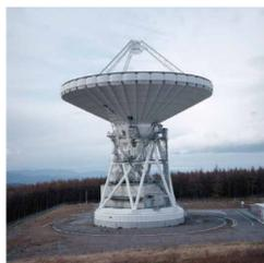
美笹局のパラボラアンテナが天頂を向いた際の高さは約70m。それは20階建ての高層ビルの高さに匹敵する。太陽光が当たって主反射鏡が歪むのを防ぐため、アンテナの背面には、日よけカバーが取り付けられている。
