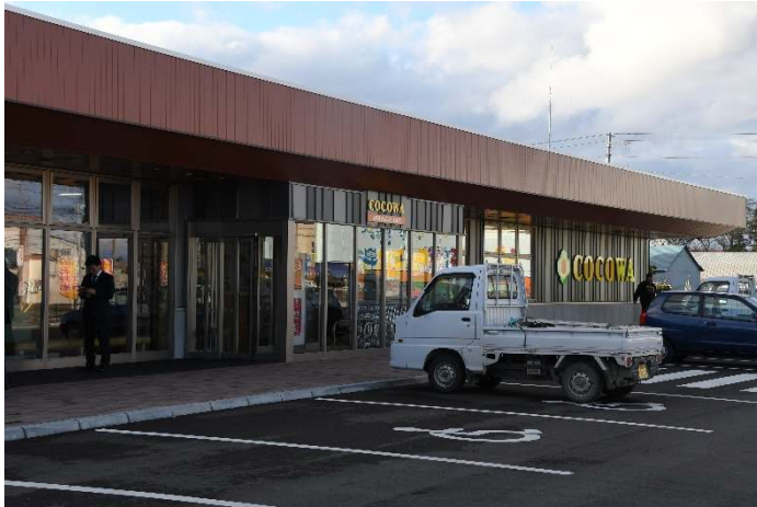
商業活性化施設COCOWAの外観
