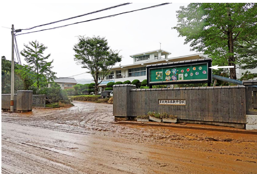
図1 佐敷中学校正門付近の洪水痕跡(写真中の白矢印, 道路から2.3mの高さ)
