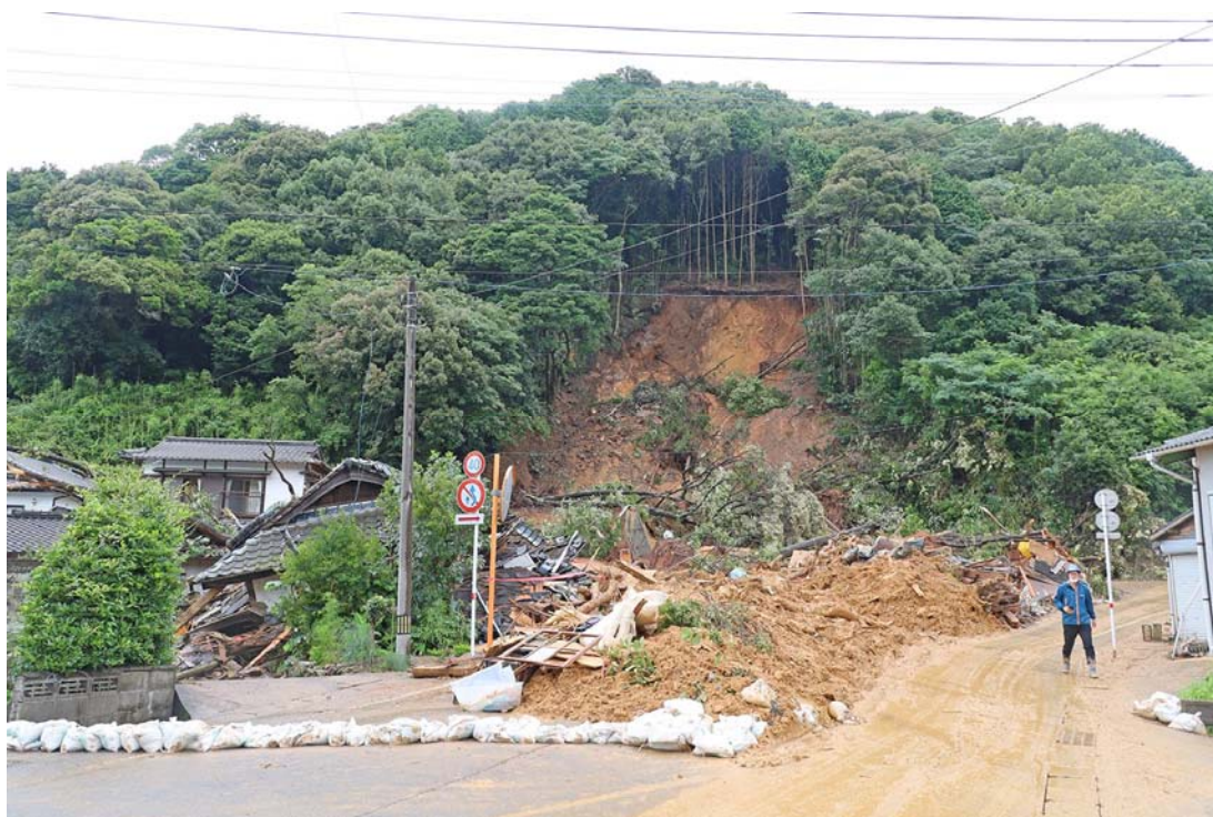
図 4 芦北町女島小崎の林地斜面で発生した崩壊による被害状況
