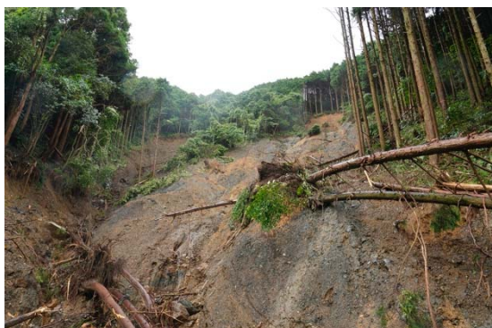
滑落崖頂部の状況 表層部が崩落する
