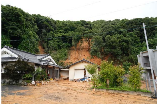
斜面上部での崩壊
