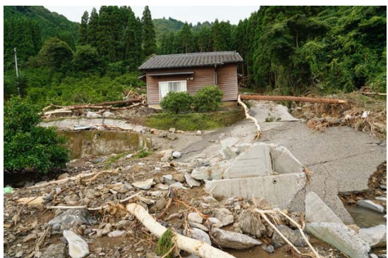
土石流により破壊された道路
