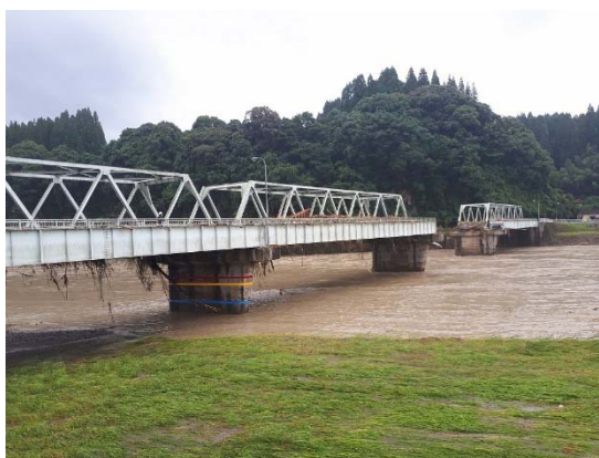
下流・右岸から
