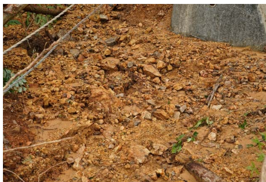
崩土は風化した頁岩，砂岩，チャート
