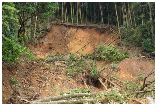
崩壊面頂部の状況
