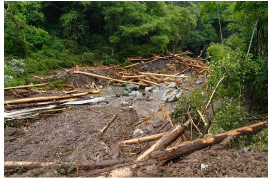
道路を越えて流下した土石流堆積物
