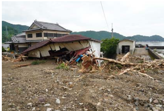
土石流堆積物に埋もれた家屋
