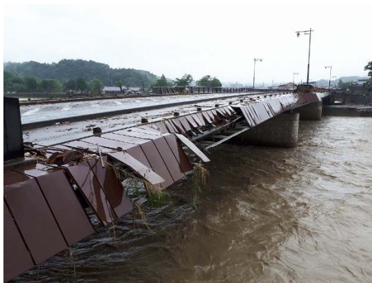
下流・右岸から
