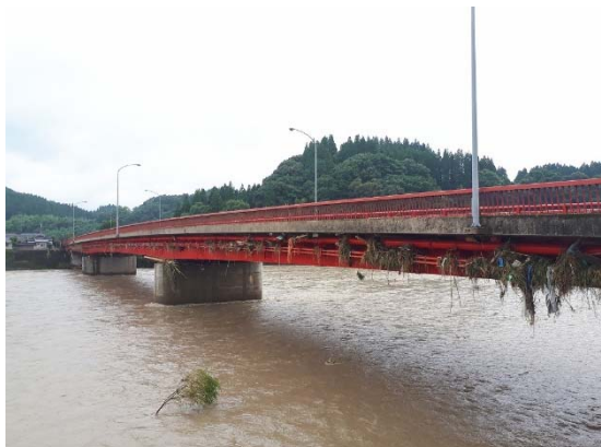
上流側・右岸から
