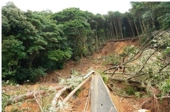
斜面对策工と斜面上部付近の状況
