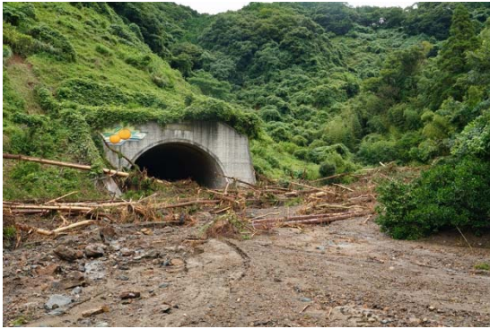
田浦トンネルを塞ぐ土石流堆積物
