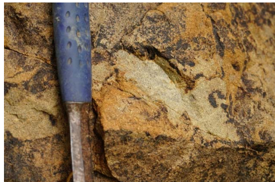
崩壊面には風化した砂岩が露出
