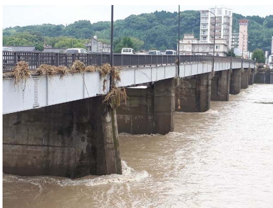
下流・右岸から
