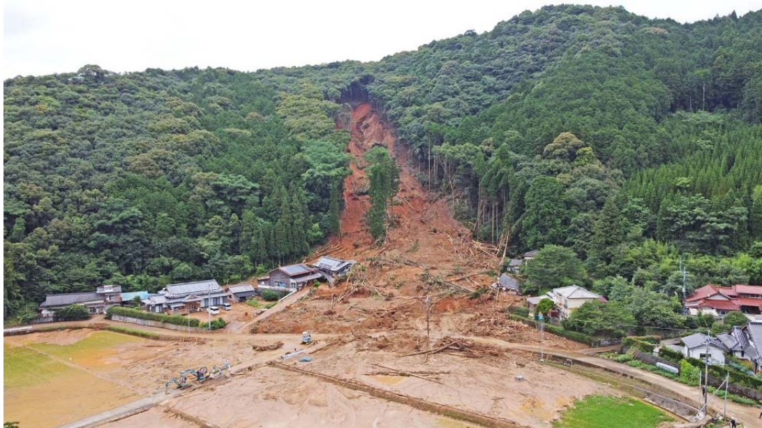
図 2 芦北町田川牛淵の林地斜面で発生した崩壊と土砂の氾濫状況
