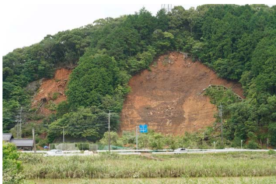
モルタル、法枠工による斜面が崩落
