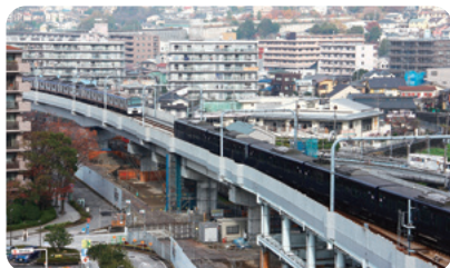
高架化区間（星川駅付近）
