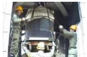
大阪府庁屋上からの 釣鐘の取り外し →
