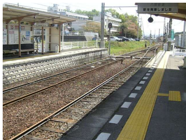
視覚障害者誘導用ブロック
