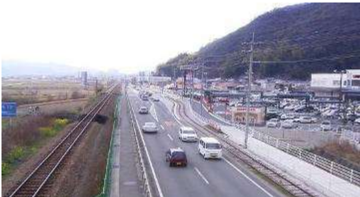
【北内停留所附近全景写真 手前側至 はりまや橋】
