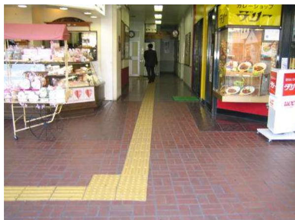
視覚障害者誘導用ブロック
