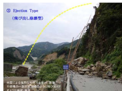
図-4 地震による強烈な水平力を受け、放物線のように飛び出す巨大岩塊
