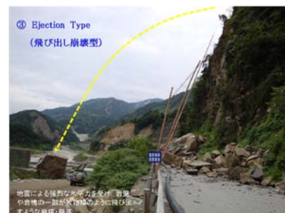
図-4 地震による強烈な水平力を受け、放物線のように飛び出す巨大岩塊
