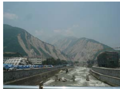
図-3 震央地の被害状況
