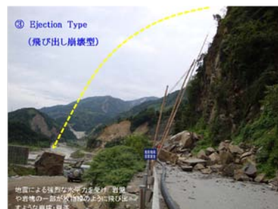
図-4 地震による強烈な水平力を受け、放物線のように飛び出す巨大岩塊
