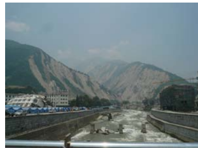
図-3 震央地の被害状況
