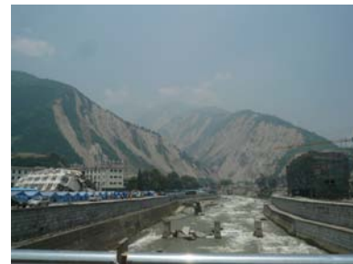
図-3 震央地の被害状況
