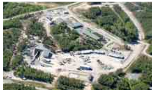
ONKALOの建設状況（2006年夏頃） （ポシヴァ社資料より引用）
