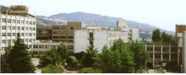
再生改修前の理学部学舎 2001(平成 13)年
