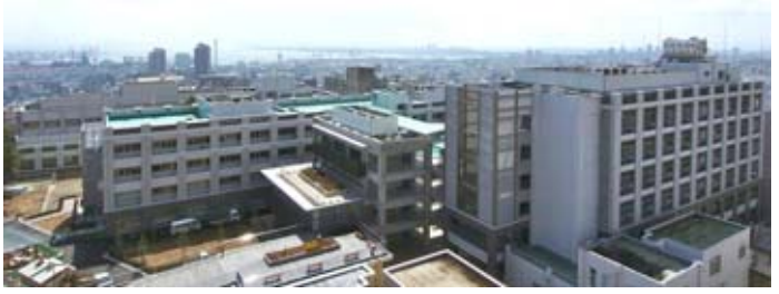
再生改修後の理学部 講義棟 Zと研究棟 A、B、C
