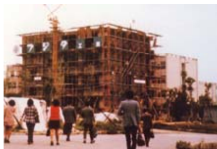
建設中の研究C棟 1974(昭和49)年
