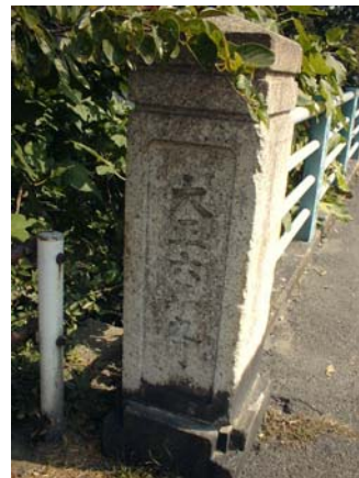
▲写真2 大正6年9月竣工を示す欄干
