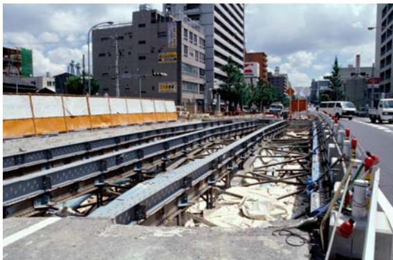
▲写真12 岩井橋の床板改修工事の状況(1)
