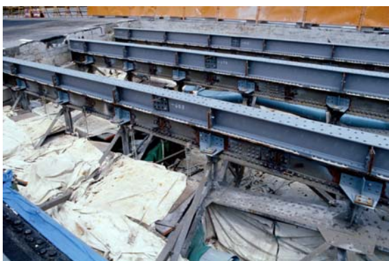
▲写真13 岩井橋の床板改修工事の状況(2)
