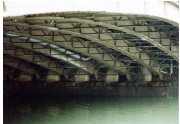
▲写真14 現在の岩井橋の下の様子
