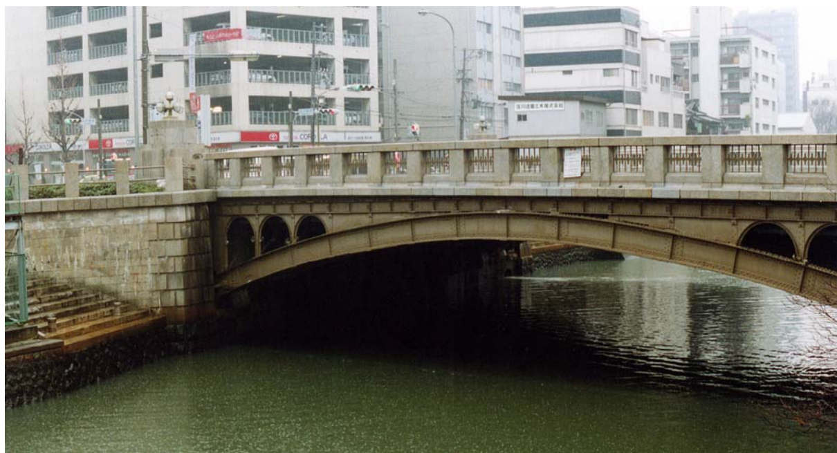
▲写真4 現在の岩井橋(堀川上流側より)
