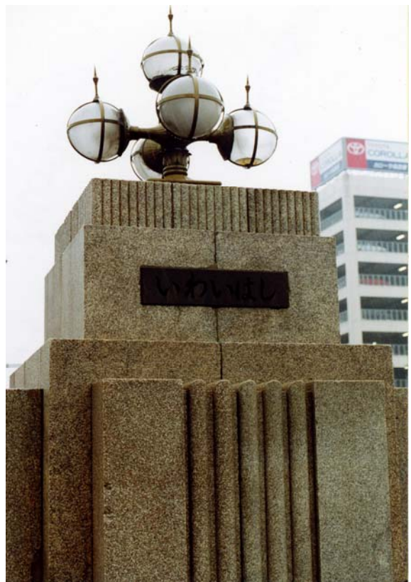
▲写真7 現在の岩井橋の電飾燈
