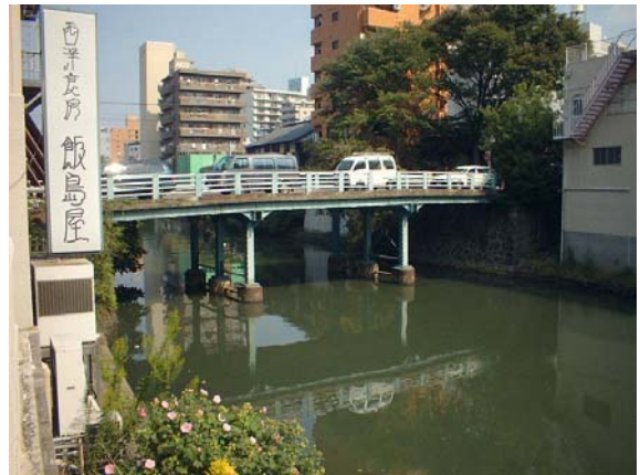
▲写真1 中橋(下流側から)
