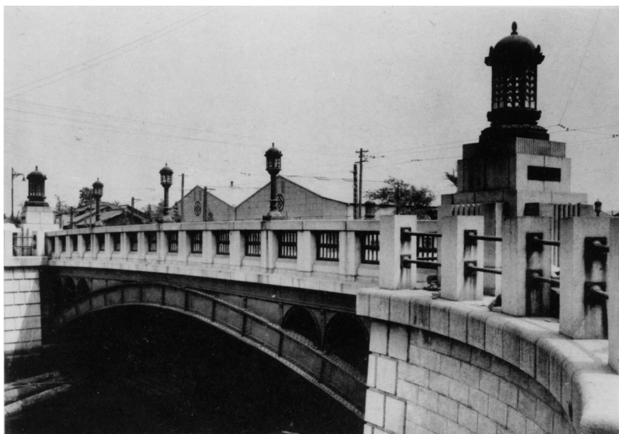
▲写真5 架橋された当時の岩井橋
