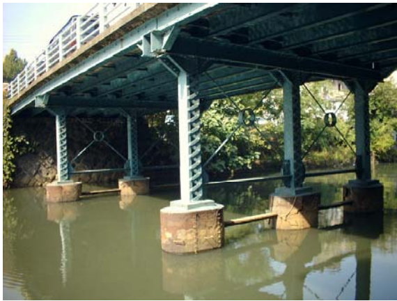
▲写真3 中橋の橋台と橋脚
