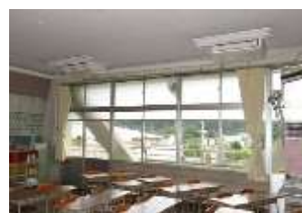
校舎の耐震工事とエアコンの設置
