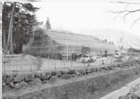
改修中の武道館
