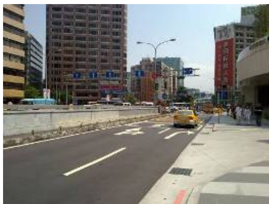
改善後雙車道
