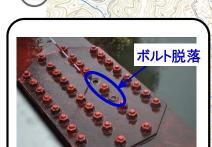
高度な専門技術が求められるアーチ橋で、健全性に大きな影響を持つ接合部などで損傷が散見
