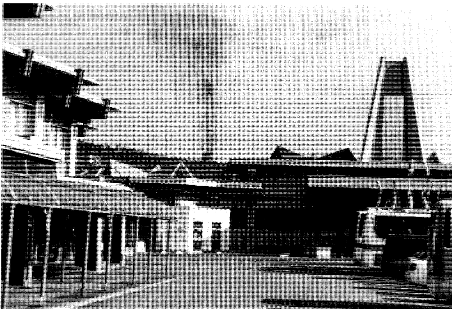
図15 はからずも黒煙が上空へ浮遊する八事斎場の火葬棟 (H10.12.29)
