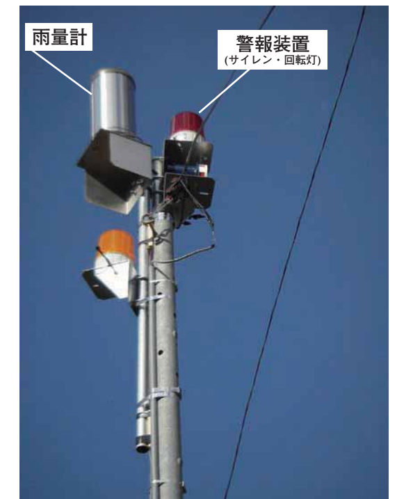
雨量計・警報装置施工例(篠堂地区)
