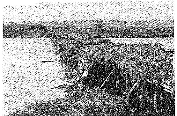
写真-7 洪水により流下物が堆積した事例 (久下橋 荒川水系荒川 埼玉県) 2)
