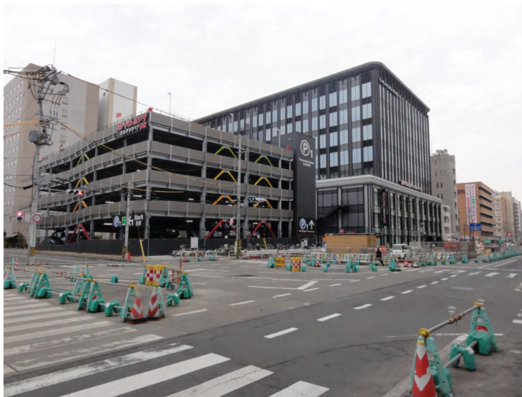
「駅東スカイビル跡地（地下鉄建設中）」
