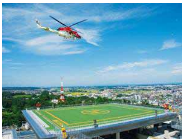
屋上ヘリポートの事例
