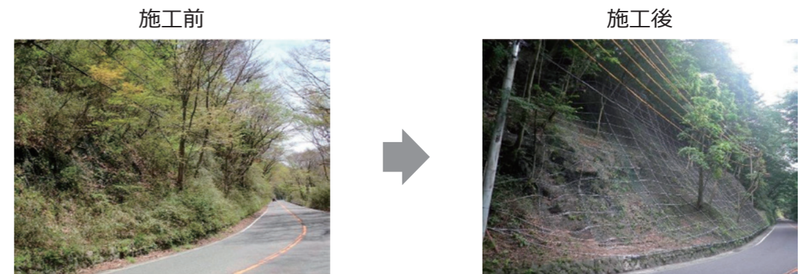
土砂崩落対策箇所の整備
