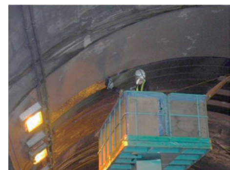
トンネルの補修例(炭素繊維シート張り)
