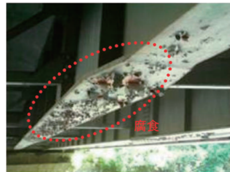
橋りょうの補修例(鋼桁の塗替え塗装)
