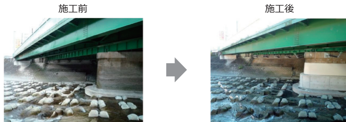
橋りょうの耐震補強の実施
