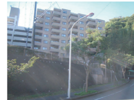
道路照明灯の更新例
