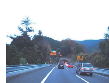
中央自動車道（小仏トンネル付近）
