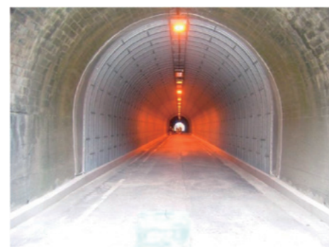
トンネルの補修例(ライナープレートの設置)
