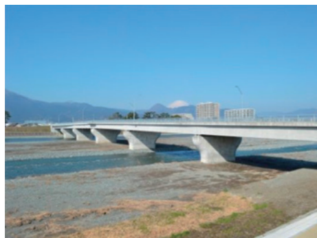
橋りょうの新設
