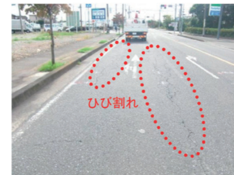
舗装の打換えの一例
