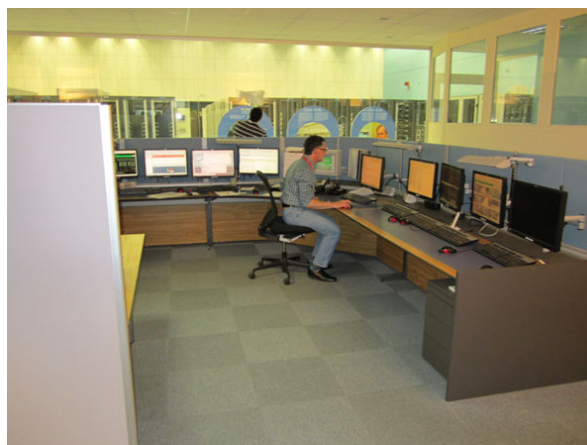
コンピュータ制御室
