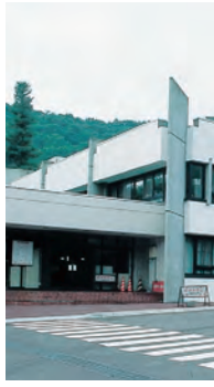
⑩ 事務棟 【昭和43年3月】 Administration Bldg
