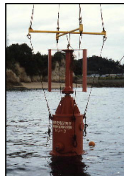
(写真 1) 第 3 回海洋実験・発電装置設置風景
