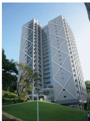
地震・風観測を行っている超高層免震建物 (すずかけ台キャンパス)
