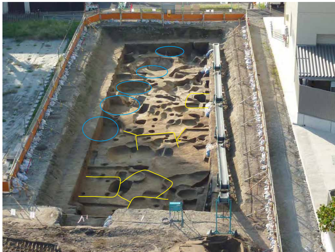
11A区4面の遺構（西から見る）水色は城下町期の井戸、黄色は平安時代の竪穴建物跡 その他は多くが城下町期のゴミ穴か柱穴
