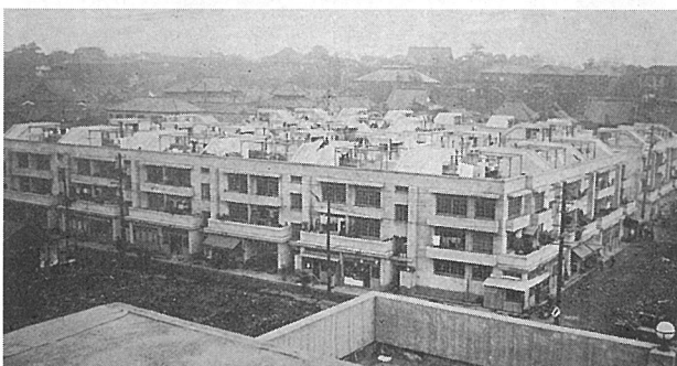
写真7 下寺第一アパートの改良工事以前の長屋の状況 写真8 同上、完成直後の状況 いずれも大阪市社会部『不良住宅地区改良事業概要』(1937)より
