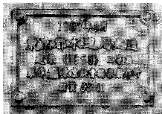
[写真-7.23:東京鐵骨橋梁製作所の橋歴版(峰谷橋)]
