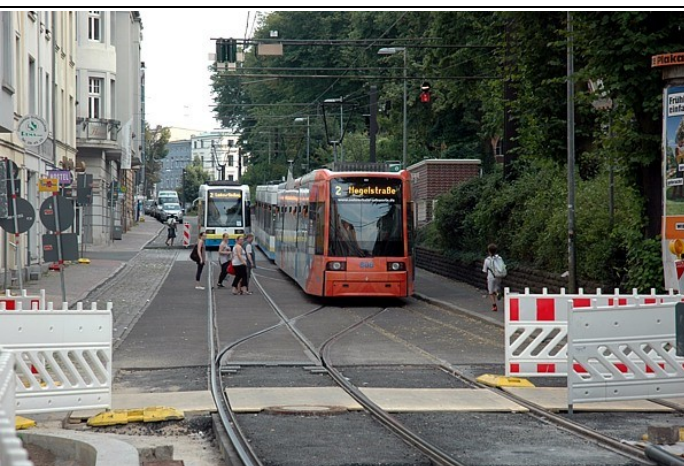
Trapez umożliwiający przejazd dwoma torami w rejonie przystanku Goethestrasse/Geschwister-Scholl-Strasse. W kolejnych etapach remontu wykorzystywana była tylko jedna, właściwa połowka przejazdu z toru na tor.
