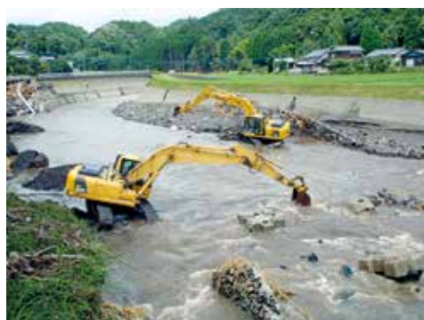
河床掘削を進め、河川流量を調整する
