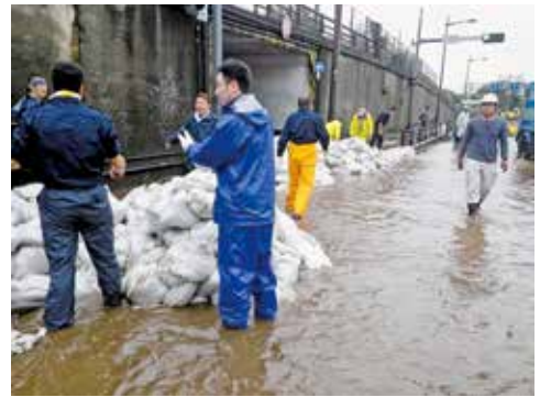
白川での土のう積み
