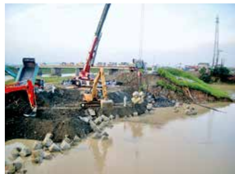
応急復旧に向けた工事に着手
