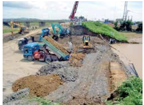
岩砕盛り土を行った上で締め固める
