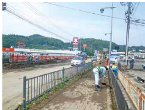
応急復旧作業は手作業も多い
