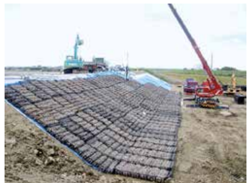
法覆護岸の施工一状況 (川表) 大型連節ブロックを表面に設置
