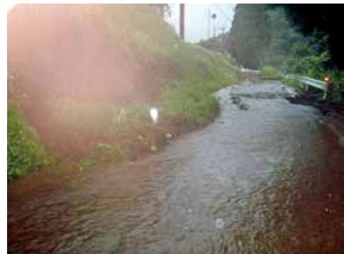
二重峠菊池線（菊池地区）の土砂崩れ
