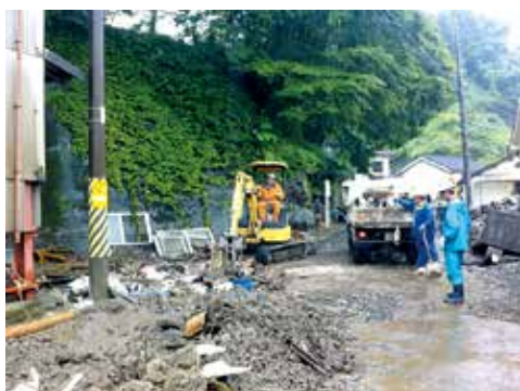
町中に堆積した土砂を処理
