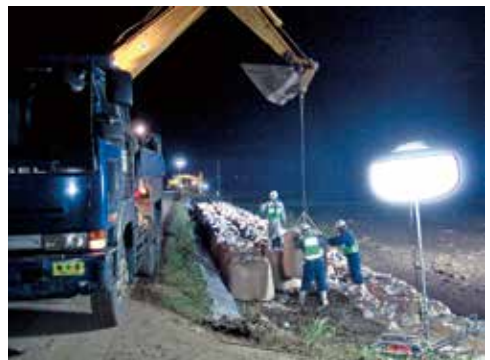
合志川（合志地区）での土のう設置作業
