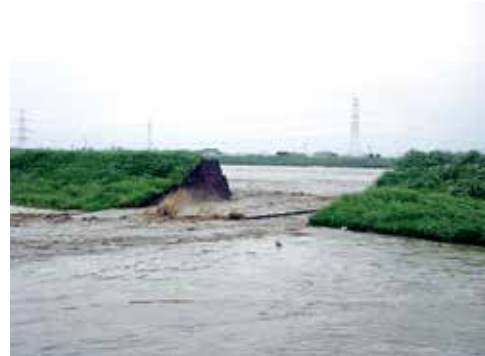
矢部川の堤防が決壊した時の様子
