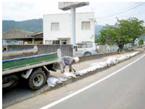
土のうの積みあげ作業は重労働だ
