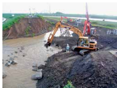
根固めブロックを置き、岩砕の盛り土を行う
