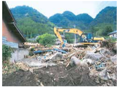
阿蘇市北坂梨の土砂崩れ復旧作業
