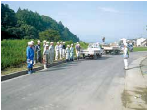
毎日朝礼を行い、作業内容を確認した
