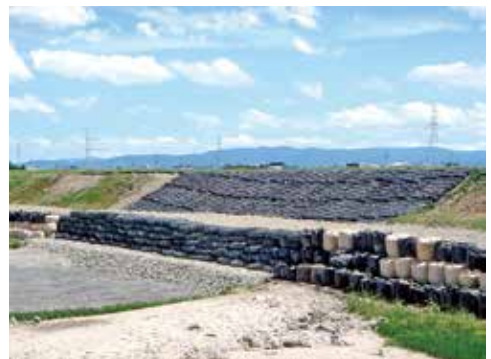
川裏岩輪砕盛り土が完了
