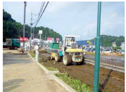
寸断された道路を応急復旧し、交通を確保
