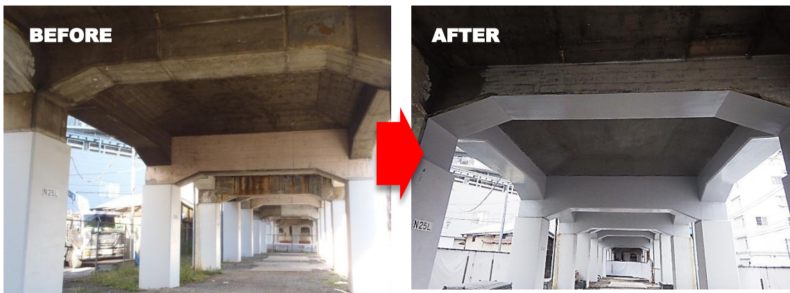
▲高架橋床板改修の様子
