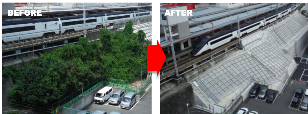
▲京成成田駅 法面補強工事の様子
