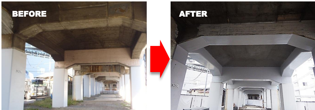
▲高架橋床版改修の様子
