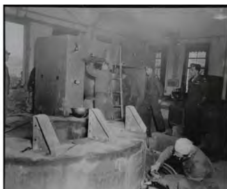
写真 47 京大サイクロトロン解体作業 1945 年 11 月 24 日（米国立公文書館所蔵 時事通信社）左の壁がぶち抜いてある。奥は鉄ヨークの分解作業、手前はコイルタンク溶断作業。
