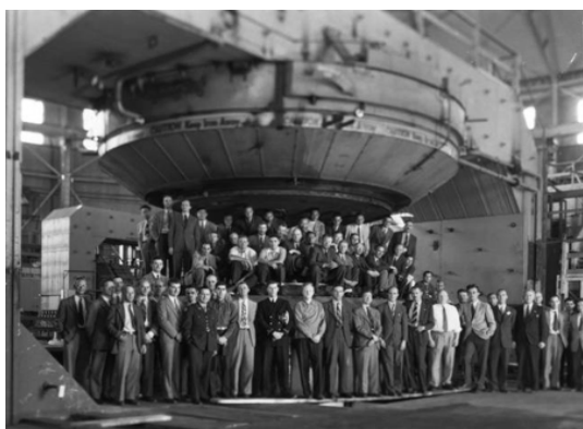
写真 28 バークレイ 184 インチサイクロトロン磁石。右はカルトロンに転用中の写真
