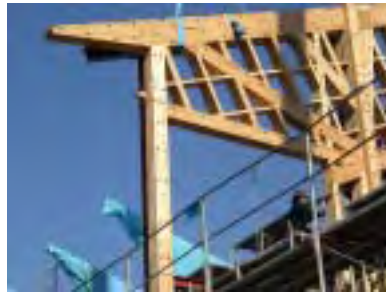
写真-7 左から接着重ね梁、稲荷山養護学校体育館フレ-ム、完成した体育館内部
