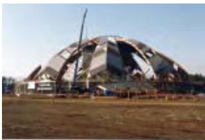
写真-5 左からカラムツ集成材によるドーム外観、内部、一般住宅用集成柱
