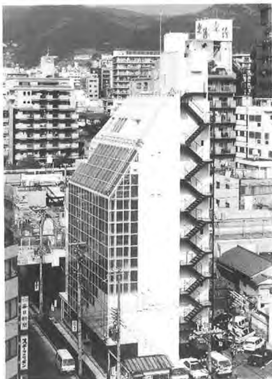
写真—1 こうべまちづくり会館
