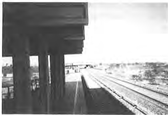
写真-5 ブラジリア地下鉄 (完成区間; 試験運転のための仮設駅)
