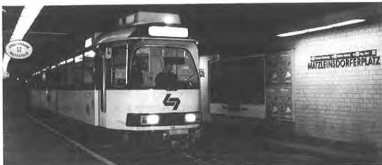
写真—17 地下化された路面軌道の駅部（ウィーン）
