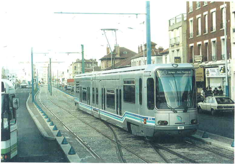
▲街路の中央を専用軌道で走行するライトレール（センターポール化も実施） —フランス・パリ市—
