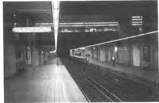
写真-4 地下の3線軌条（ホームは高低両方有り）
