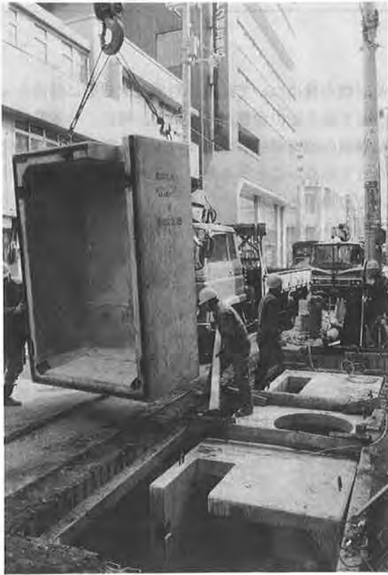
写真一三 電力用人孔据付
