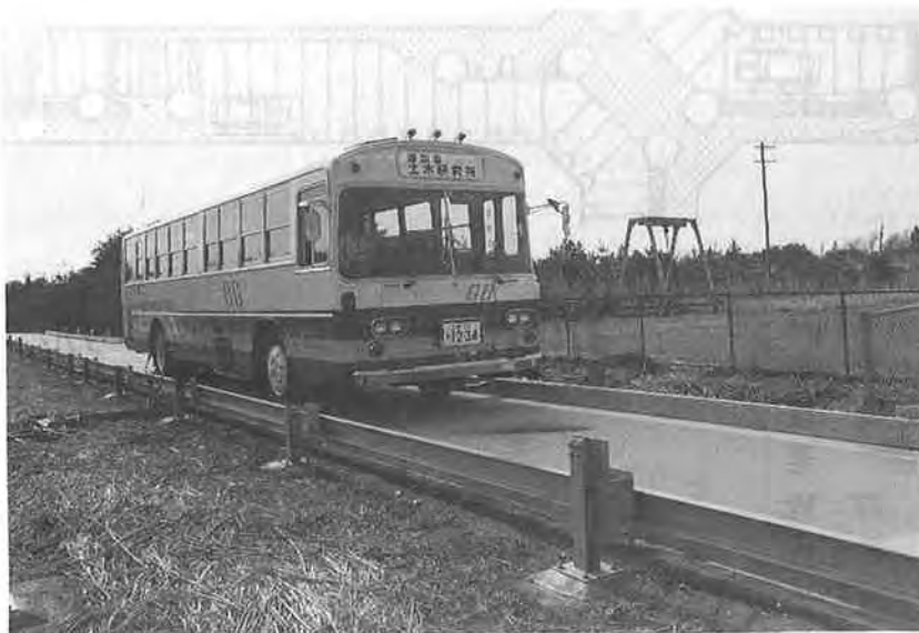
写真一 1 実験用走行路内のガイドウェイバス
