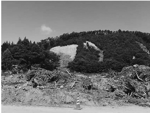
写真11 先大戸地区の斜面崩壊
