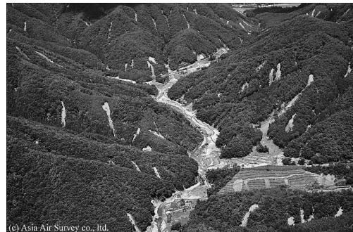
写真1 篠堂地域の斜面崩壊の状況 1
