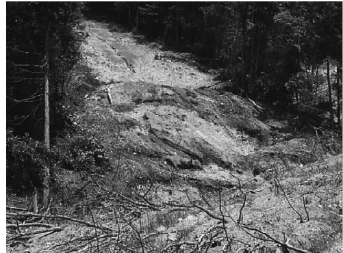
写真12 先大戸、篠堂の中間にある県道445号線沿いの斜面における崩壊
