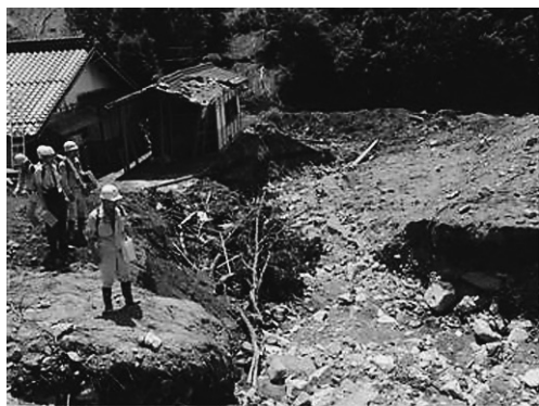
写真18 県道445号線から篠堂川、左は半壊の家屋、右の家屋は全壊して土石流、流木とともに篠堂川に流された
