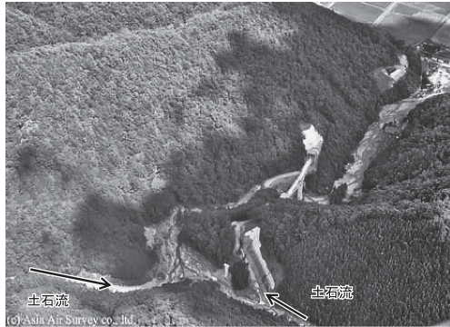
写真9 上川西地区庄原ダム建設現場における土石流の状況 突然の豪雨と土石流の発生により写真中央部にある橋梁工事に従事していた13名が孤立し、翌朝ヘリコプターで救出された(位置は図3の⑤)
