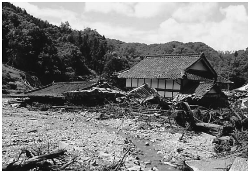
写真5 篠堂川右岸で発生した土石流による家屋の被害（位置は図3の②）
