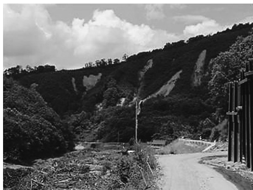
写真16 溪流出口付近の斜面崩壊状況
