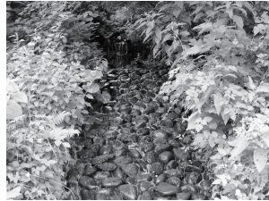
子持沢斜路工（被災前） 表面が15～25cm程度の玉石状で、流出防止のためやや細長の石材が主体
