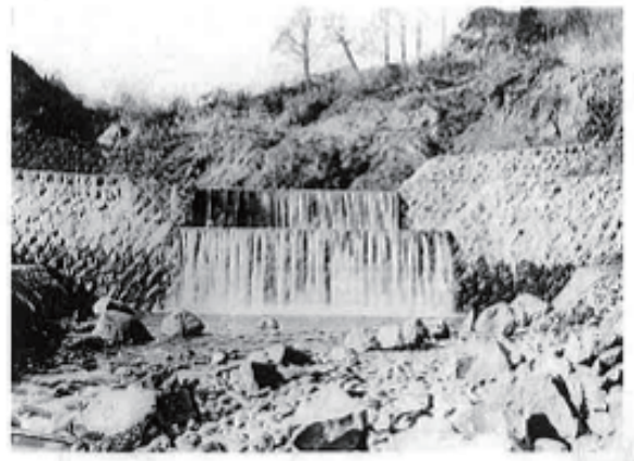
図-2 鎌倉沢川における砂防施設(竣工時)
