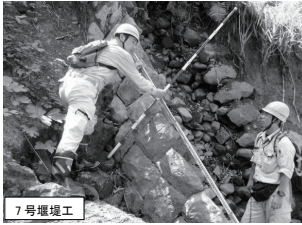
7号堰堤工 石材表面形状は、長辺と短辺の長さが異なるタイプの組み合わせが主体 35cm×30cm程度と45cm×30cm程度
