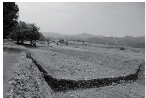
図4 下流に現存する建設当時の流路工
