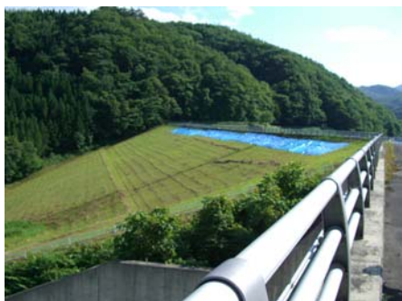
写真-25 衣川1号ダム
