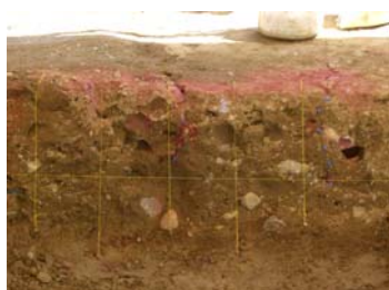
写真-22 コア部のクラック深さの確認
