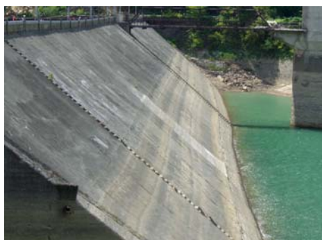
写真-18 表面遮水壁の様子
