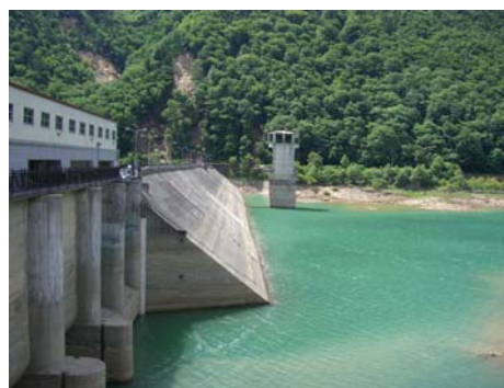
写真-15 石淵ダム（上流側）
