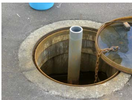
写真-3 層別沈下計の突出
