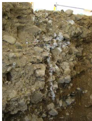
写真-21 フィルター部のクラック深さの確認
