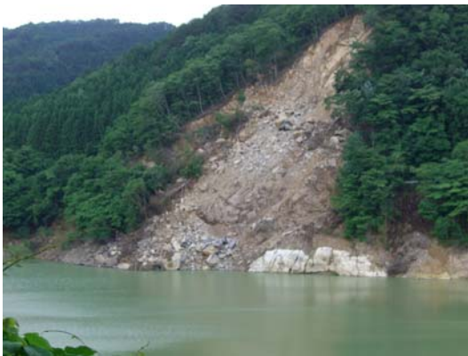
写真-12 土砂崩壊の様子
