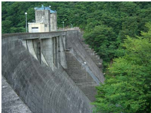
写真-8 栗駒ダム
