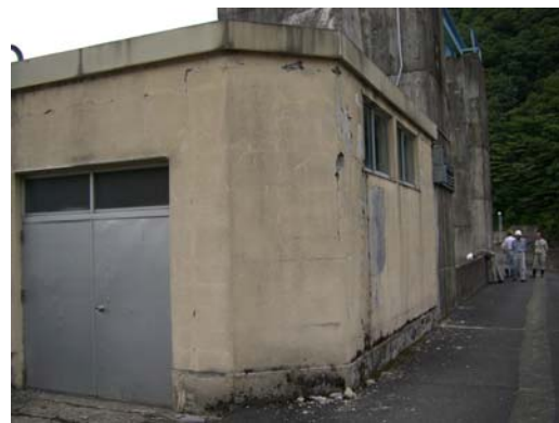
写真-9 ゲート室上屋
