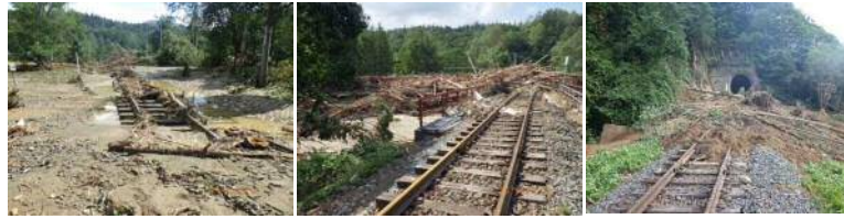
【土砂流入】 根室線 幾賀～新得 108k～113k付近 複数箇所
