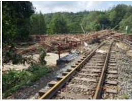
根室線 落合～新得 111k985m付近 第1ルーオマンソフチ川橋りょう
