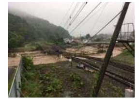
【橋りょう流失・路盤流出】 根室線 新得構内 下新得川橋りょう
