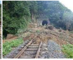
根室線 落合～新得 113k194m付近 第4落合トンネル入口
