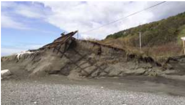
58k925m 付近の状況写真③ (10/5 現在)
